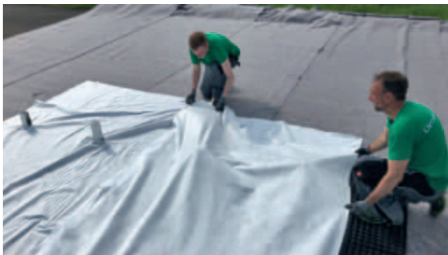
Abbildung 17: Zweite Vliesreihe verlegen.
