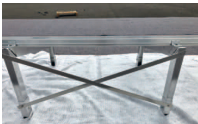
Abbildung 31: Fertiggestellter Windverband.
