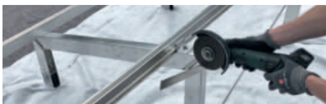
Abbildung 30: Abschneiden des Überstands beim Windverband.
