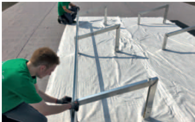
Abbildung 23: Einhängen der unteren Modulschnellmontageschienen.
