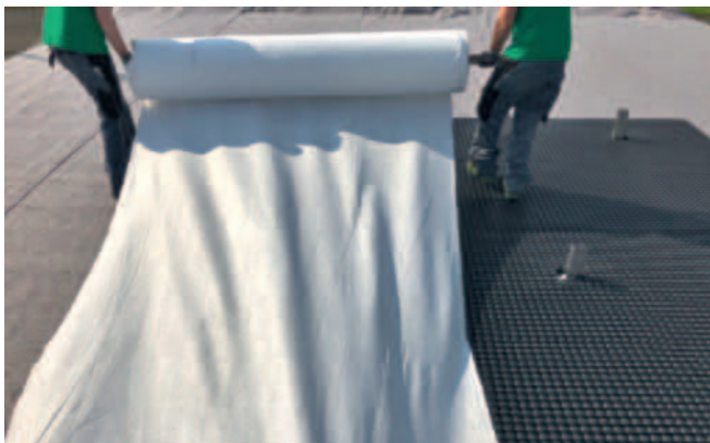
Abbildung 11: Ausrollen des Filtervlieses.
