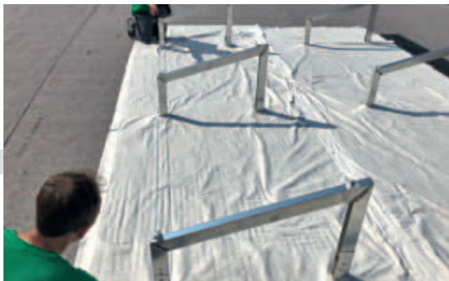
Abbildung 22: Ausrichten der Reihe mithilfe einer Schnur.
