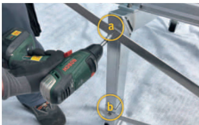
Abbildung 29: Position der Bohrlöcher.
