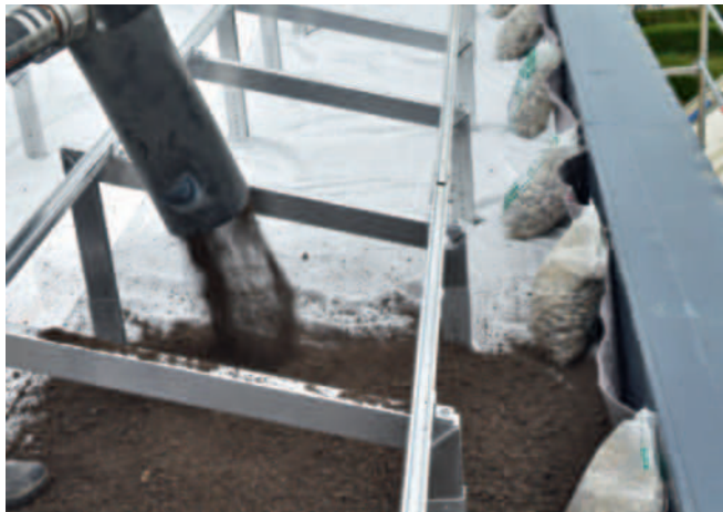
Abbildung 33: Aufblasen des Substrats.
