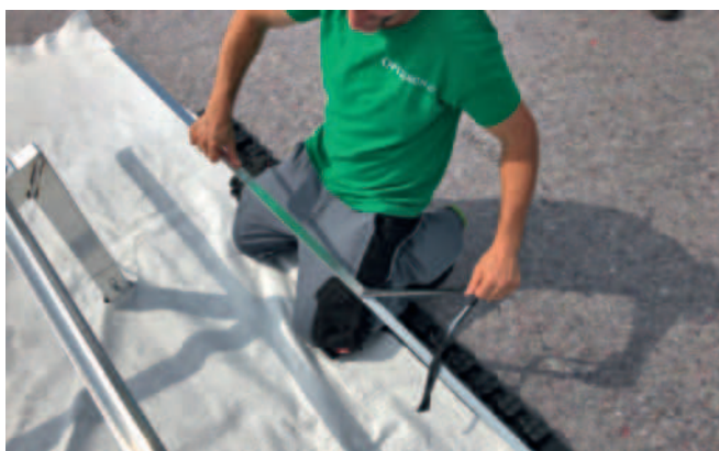
Abbildung 27: Entfernen der Schutzfolie des Windverbands.
