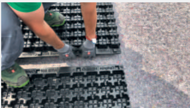
Abbildung 9: Klicksystem schließen.
