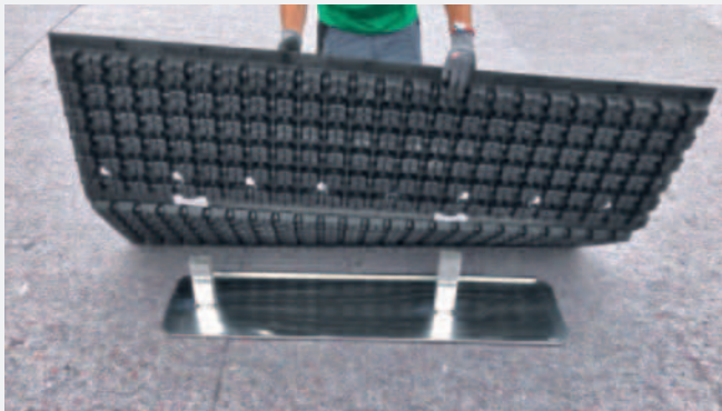
Abbildung 5: Auslegen der Bodenplatte mit WRB 8oFMA.
