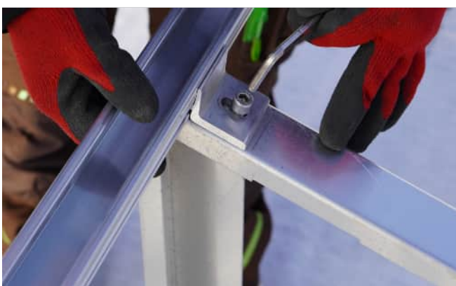
Abbildung 25: Schienenhalterungen festziehen.
