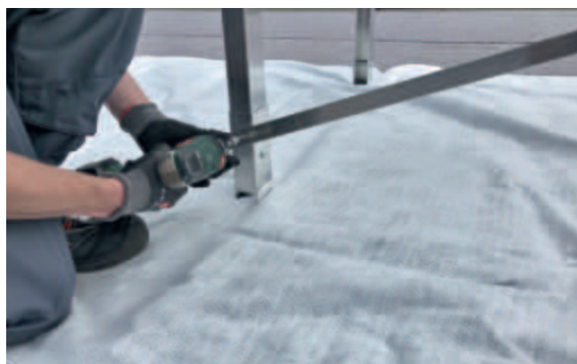
Abbildung 28: Befestigen des Metallstreifens.
