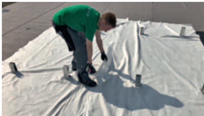
Abbildung 18: Überlappungen fixieren.
