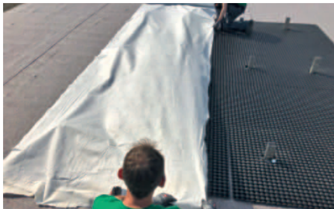
Abbildung 12: Filtervlies glattziehen.
