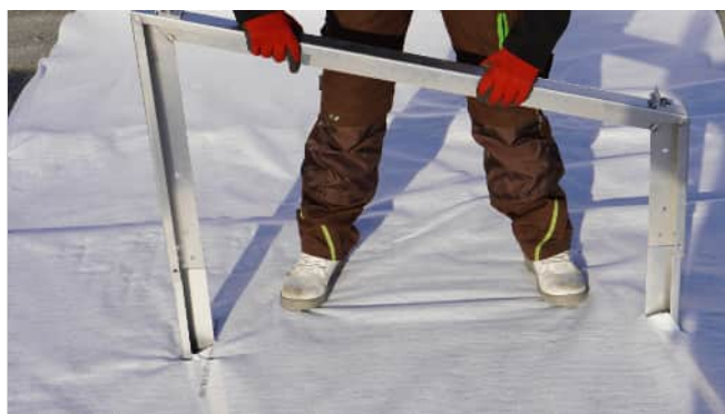
Abbildung 20: Installation des Bügels auf der Bodenplatte.
